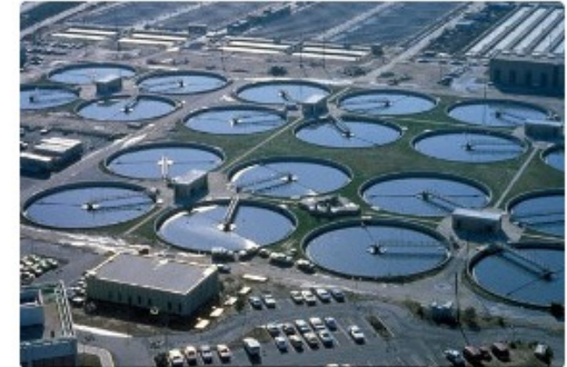
Station d'Épuration des Eaux Usées
